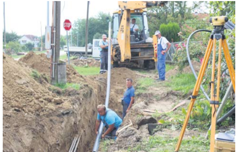
Radovi na rekonstrukciji ulice Sv. Križa
