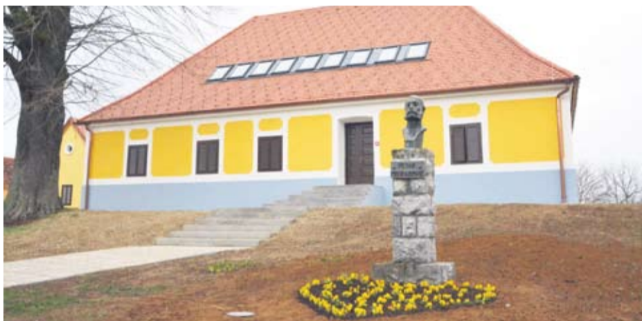
Novo lice rodne kuće Petra Preradovića
