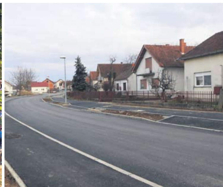
Rekonstrukcija Ulice Sv. Križa u Milanovcu
