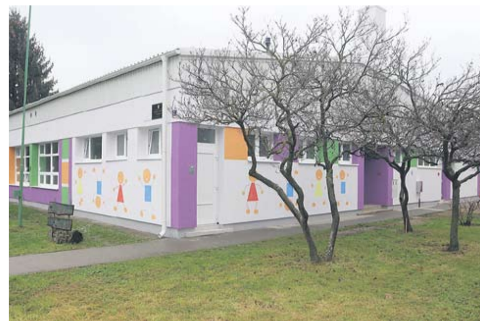
Energetska obnova - DV Cvrčak Virovitica, zgrada 2
