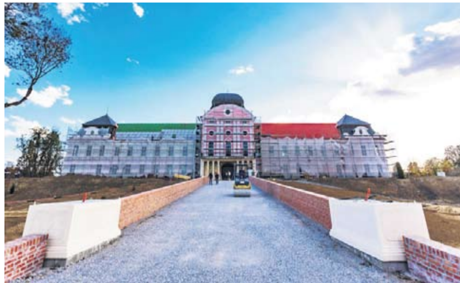
Obnova Dvorca i parka jedan od najvažnijih projekata
