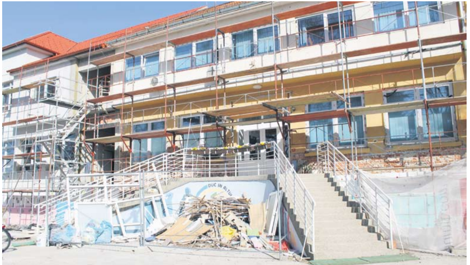
Radovi na novoj zgradi se privode kraju
