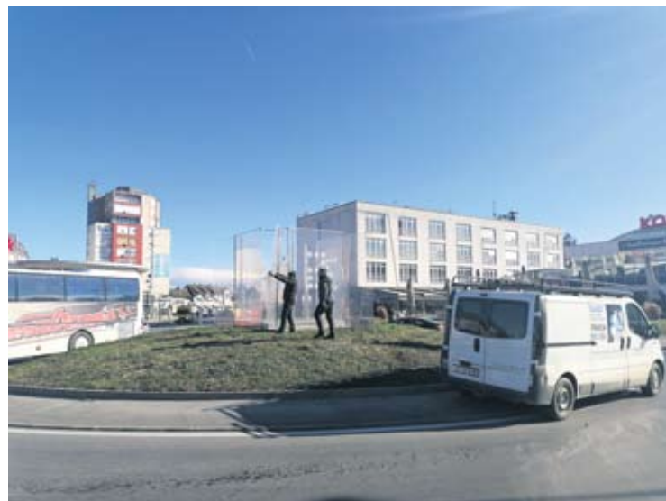
Odmah se krenulo u sanaciju štete
