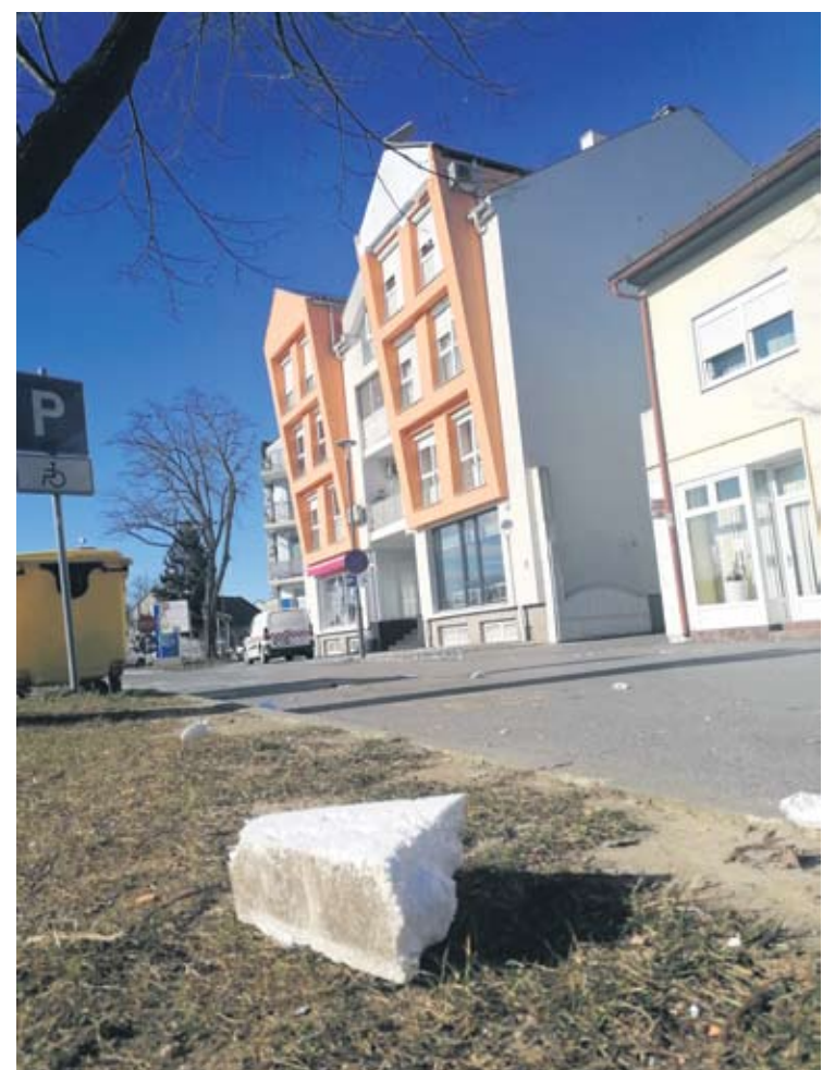
Dio fasade odlomio se na novoj zgradi
