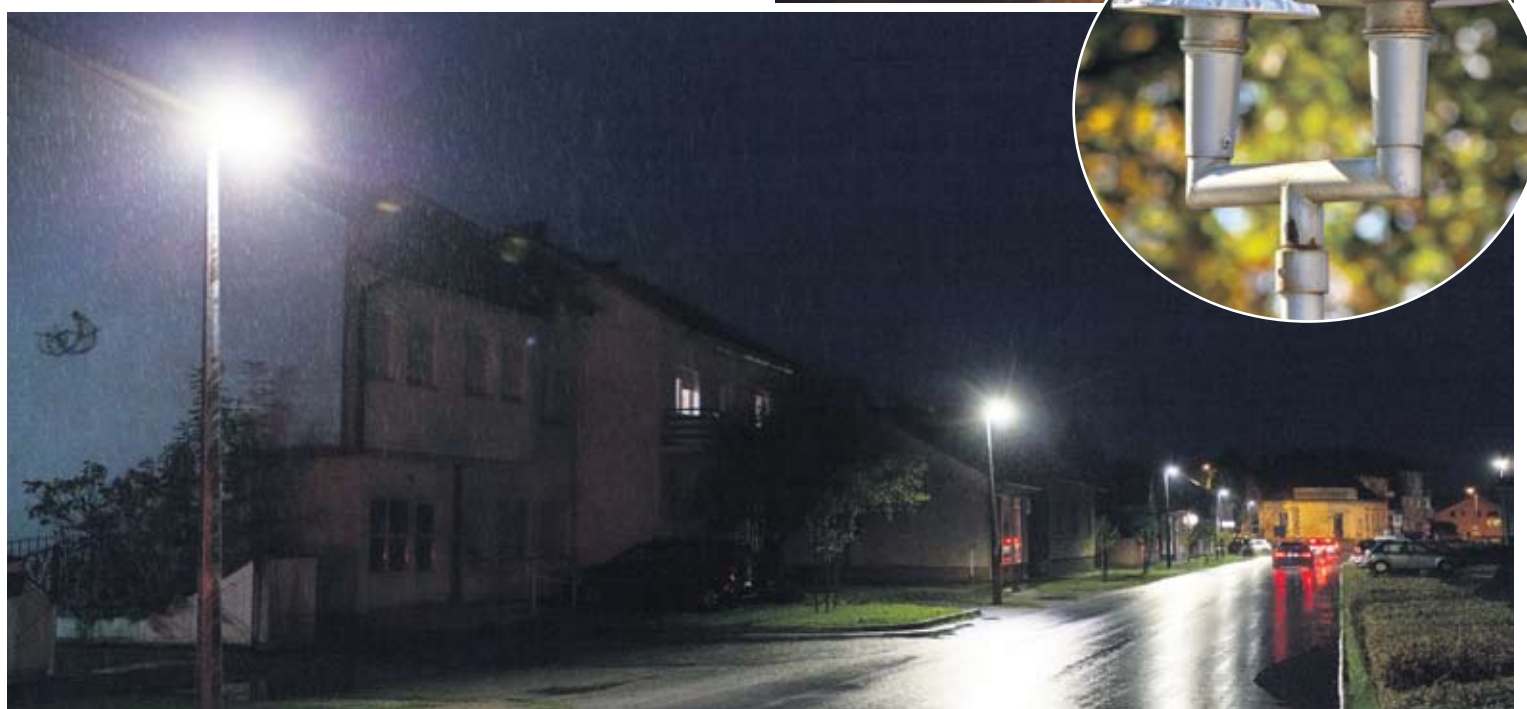
Grad Virovitica kreće u modernizaciju i rekonstrukciju postojećeg sustava javne rasvjete
