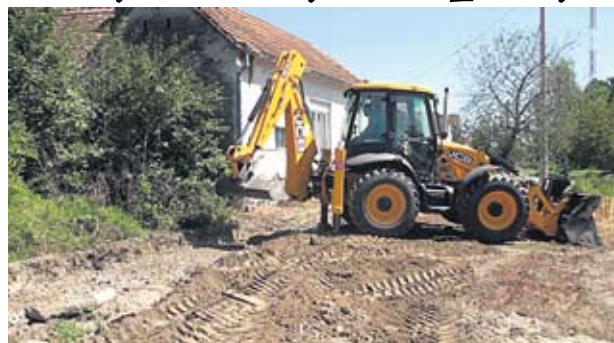
U 2021. i radovi na uređenju kanalizacije
