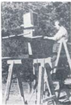
Priključenje antene na antenski ormarić
