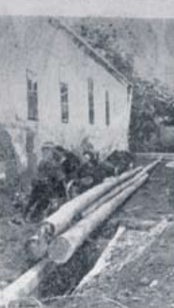
Postavljanje antenskog stupa bio je složen posao
